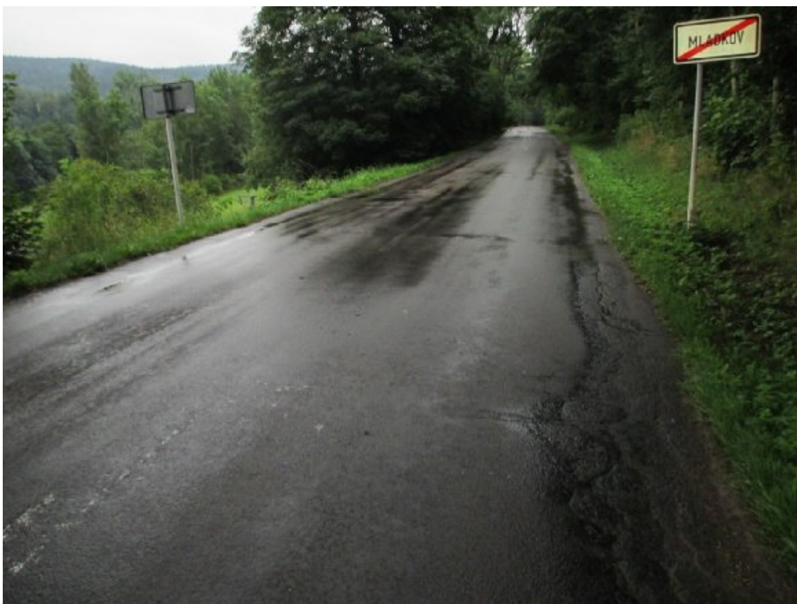
F10, km 44,110+ Konec obce Mladkov; síťové trhliny, olamování okrajů vozovky, plošné deformace, vysprávk tryskovou metodou
