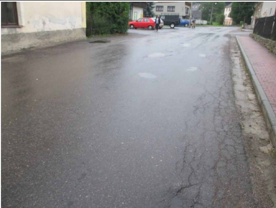
F03, km 43,410+ Mladkov; síťové trhliny, plošné deformace, vysprávk
